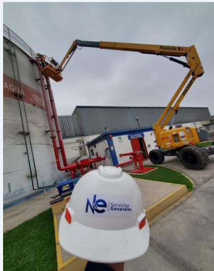
TRABAJOS EN ALTURA
