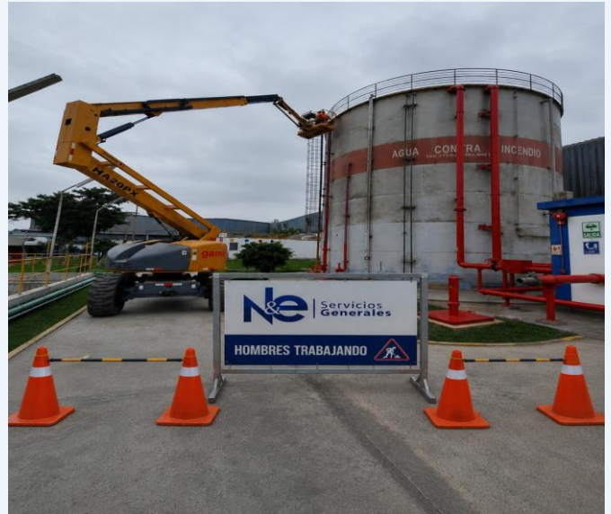
TRABAJOS CON MANLIFT
